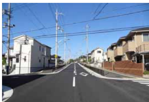
都市計画道路 山手環状線（西工区）
