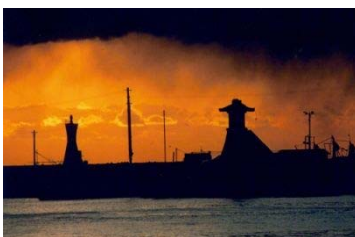
明石港旧灯台 憩いのポイント
