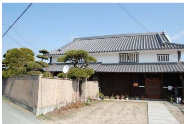
重要建築物の改修
