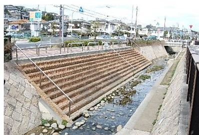
階段状とし歩道と一体となった親水護岸（朝霧川）
