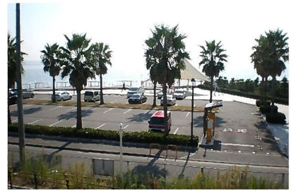
隣接する公園と一体となった緑豊かな空間を形成（松江海岸休憩施設）
