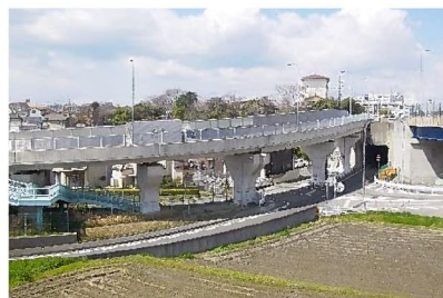
シンプルな収まりとなった桁と橋脚の接合部（藤江線）
