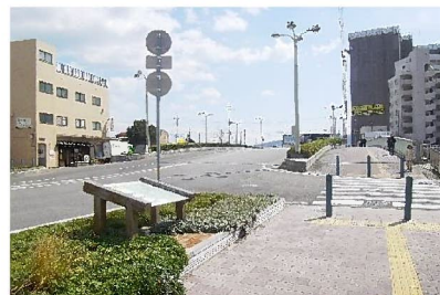
道路の延長としてつながりのある橋上空間（錦江橋）
