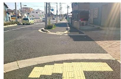
車道と歩道の段差が解消され、人に優しい路面を形成（黒橋線）
