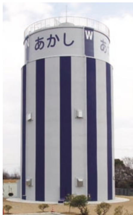
西部配水場内の配水塔(平成20年3月完成)
