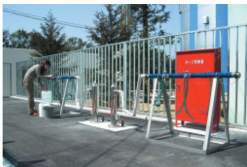
また、本体工事に併せて、外側道路から自由に使用できる位置に配水塔から直結した応急給水装置や消火栓も配備しています。
