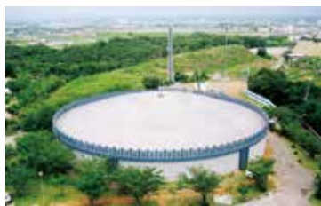
浄水を貯留するPCタンク
