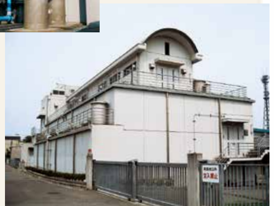
高度浄水処理棟
