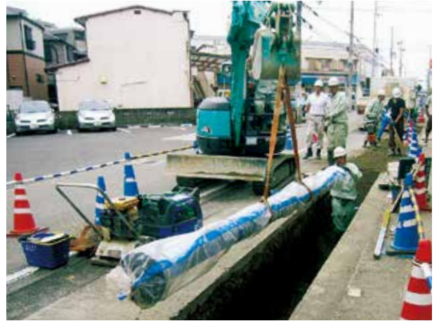
水道管耐震化工事の様子
