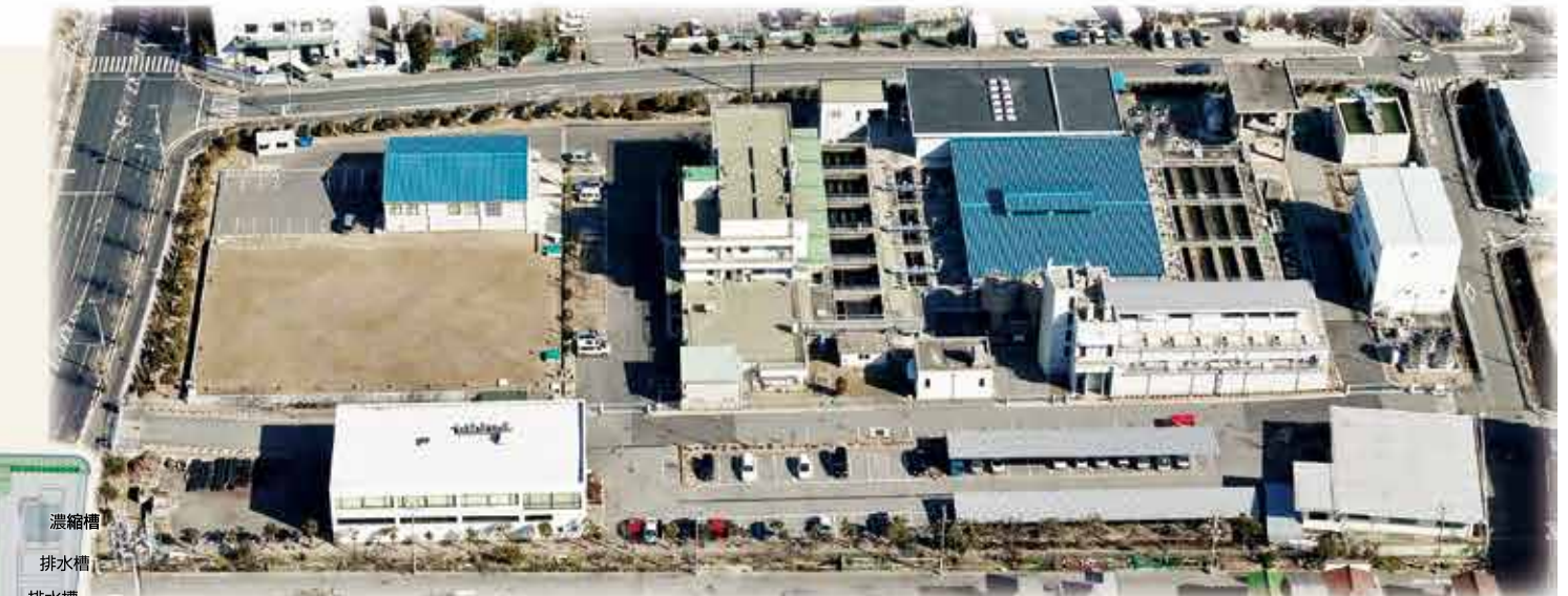
明石川浄水場
