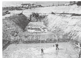
野々池の底を掘り下げる工事の様子
