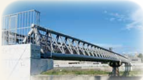
明石川に架かる水管橋
