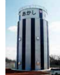
西部配水場配水塔
