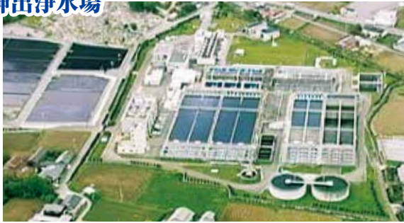
県の浄水施設 神出浄水場
