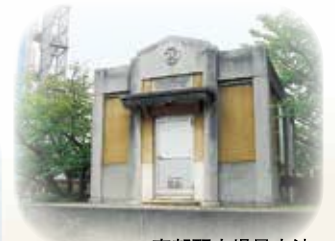
東部配水場量水池
