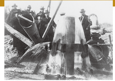
吹き上がる地下水
