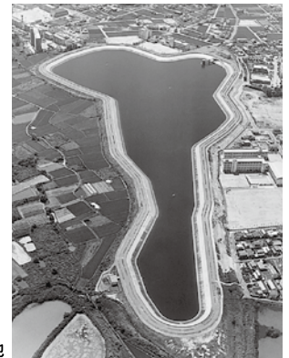
完成した野々池貯水池
