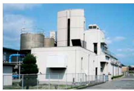
明石川浄水場高度浄水処理施設
