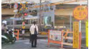
来年春に「(仮称)南畑歩道橋」が新設予定
