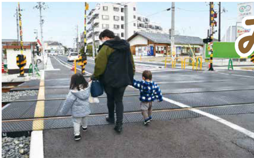
安全に渡れるように踏切を広げ、歩道を設置(東二見農協前踏切)
