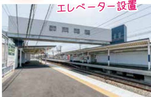
エレベーターが設置され、車いすでの移動も可能に(山陽江井ヶ島駅)
