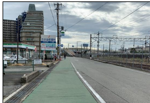
路側帯のカラー舗装(駅北側)
