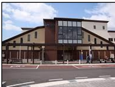
橋上化によりバリアフリー化を実施(JR 魚住駅)
