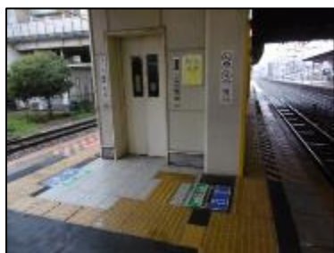
駅構内のエレベーター
