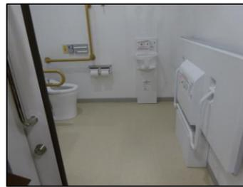
●多目的トイレ内にある大型ベッドのサイズが大きい。バギータイプの車いすで中に入ると、室内での転回が困難。
