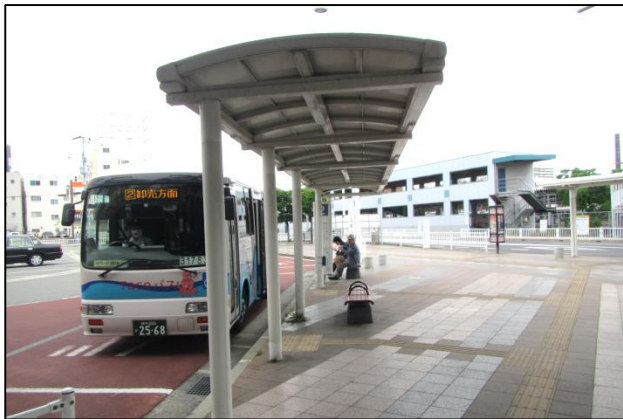
バス停の整備、誘導ブロックの設置、歩道の段差・勾配の改修
