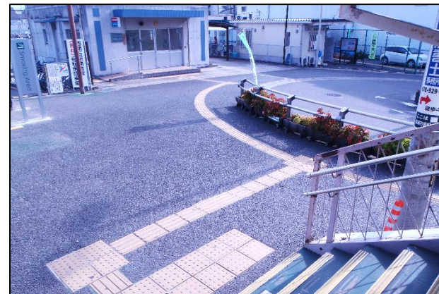
誘導ブロックの設置
