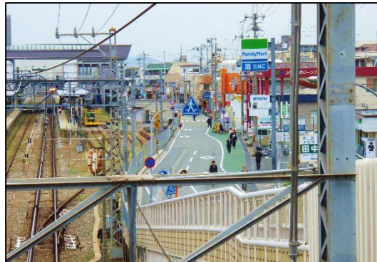
カラー舗装による歩車道分離
