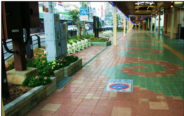
放置自転車の解消、歩道段差解消・幅員確保、誘導ブロックの改修
