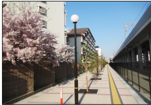
立体交差化にあわせた歩道の整備
