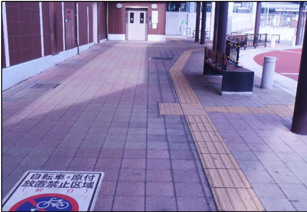
歩道の段差・勾配の改修、誘導ブロックの改修、音声付き案内標識の設置
