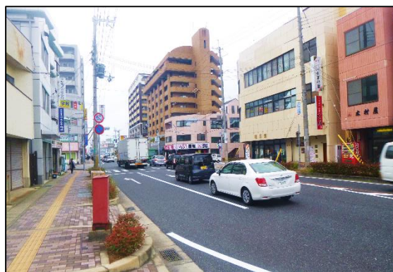
歩道の段差・勾配改修・幅員の確保
