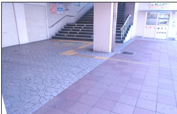
歩道の段差・勾配の改修、点状誘導ブロックの設置
