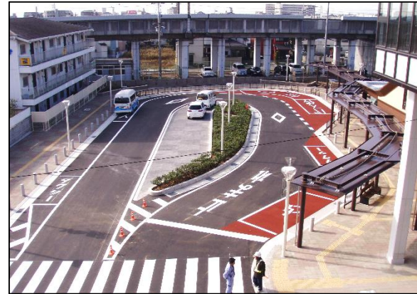
障害者用乗降場の設置
