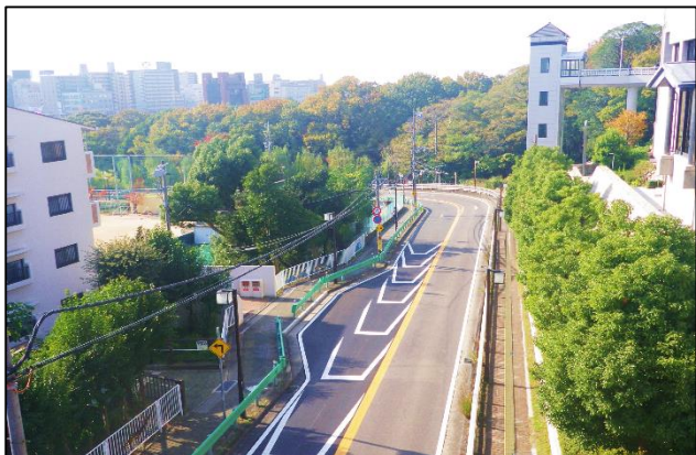
歩道の段差・勾配改修、点状誘導ブロック設置、バス停の整備、ガードレール改修
