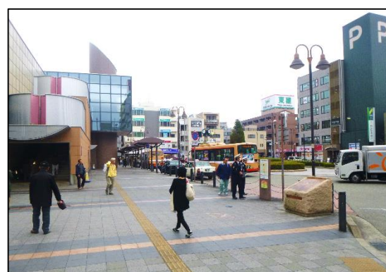
駅前広場 誘導ブロックの改修
