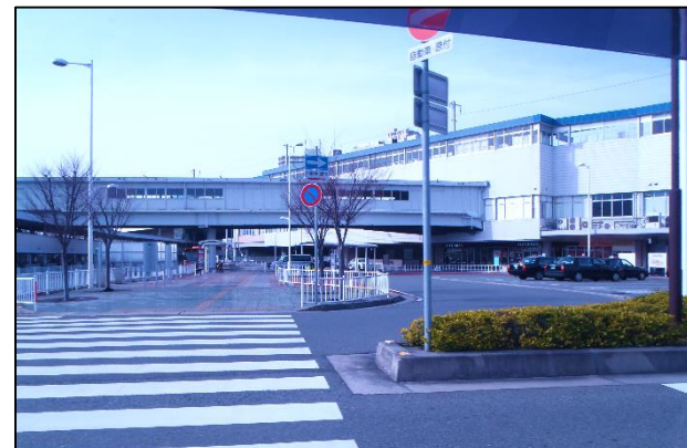
駅前広場の整備、バリアフリー歩道の設置、障害者用乗降場の設置
