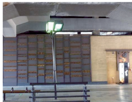
図 4-3 明石駅東側高架下の照明 LED 化
