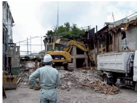
図 4-24 解体現場のパトロール
