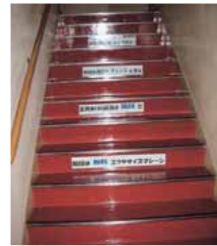
市立保健センター内階段
