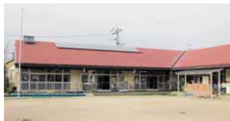
市民からの寄付により設置された 太陽光発電施設（岡山市）
