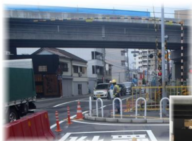
国道2号線立体交差前
