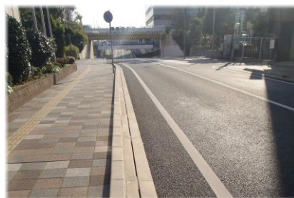
市役所付近の都市型側溝と排水性舗装
