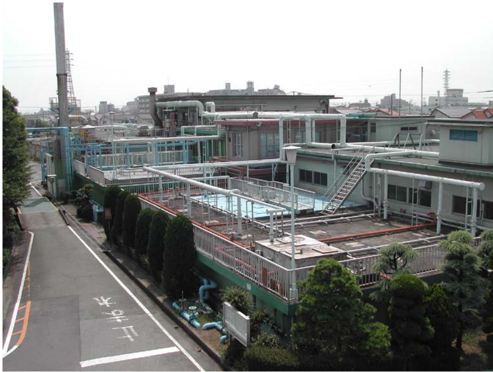
魚住清掃工場
