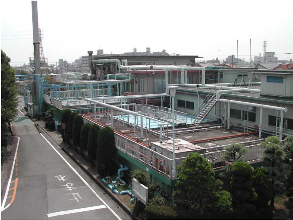
魚住清掃工場
