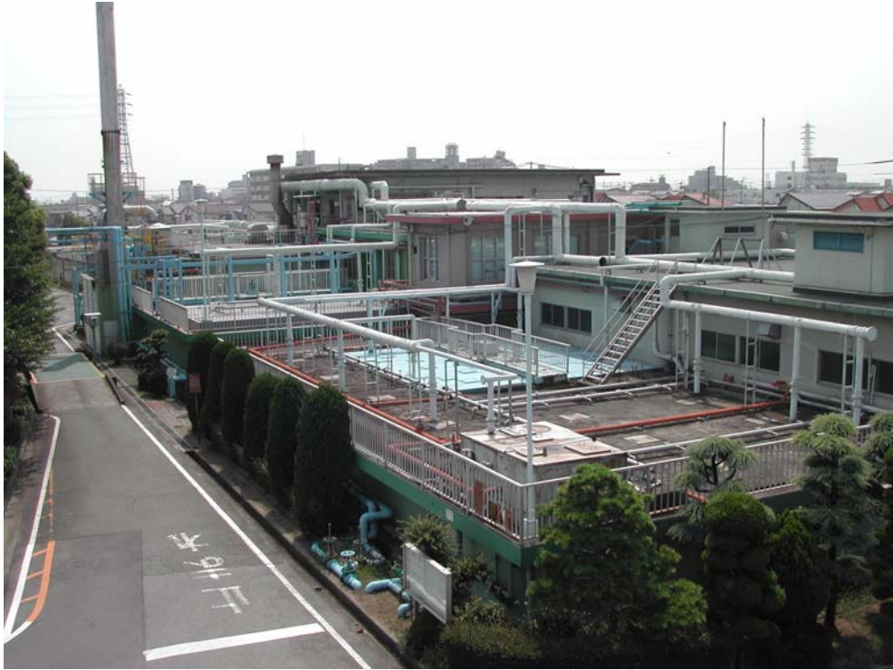
魚住清掃工場
