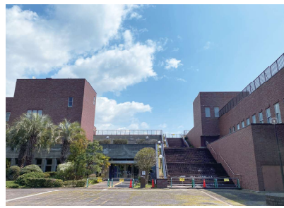
昭和49年県立図書館と合築で開館
