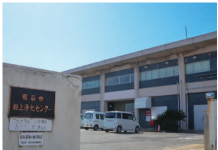
築後51年の船上浄化センター
