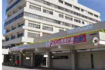
老朽化が進む現庁舎
