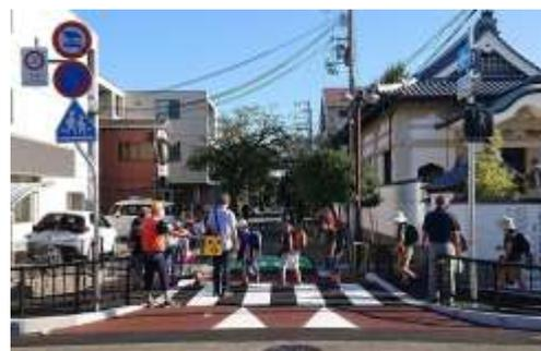
※2 歩行者の安全を確保するため車両速度を抑制する「ハンプ（凸部）」を設置した横断歩道
