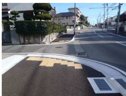
【段差解消グレーチングの設置】
