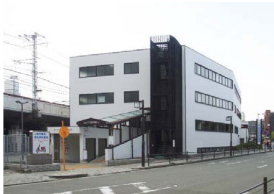
明石駅東自転車駐車場
