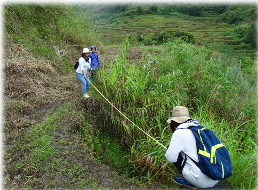
大雨などにより、棚田が崩落してしまった。配属先のスタッフが、崩落箇所を測量している。
