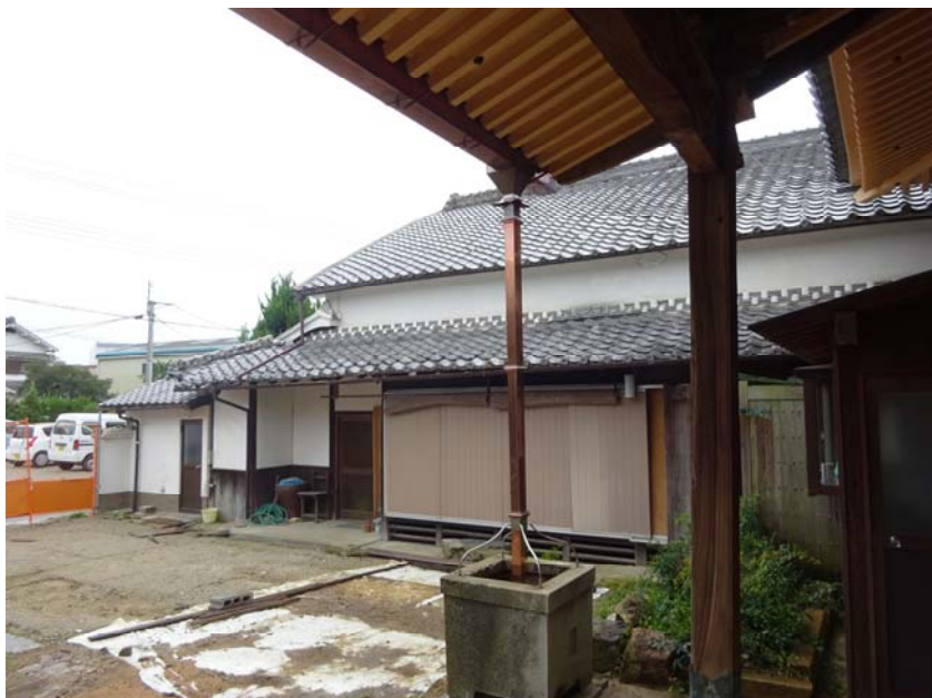
西光寺庫裏（本堂から）
