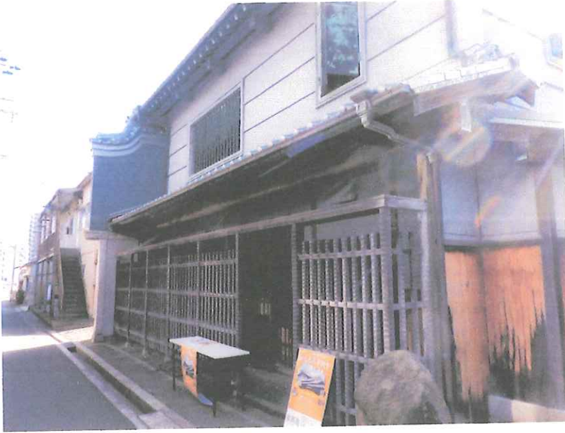
材木町安藤家北西から
