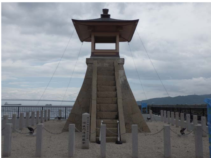
改修後の波門崎燈籠堂
