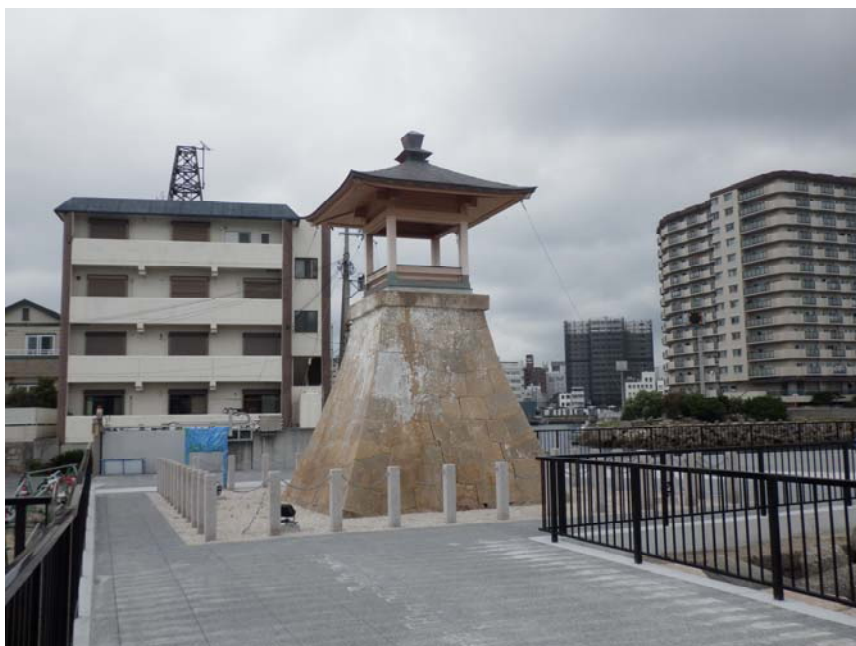
改修後の旧波門崎燈籠堂
