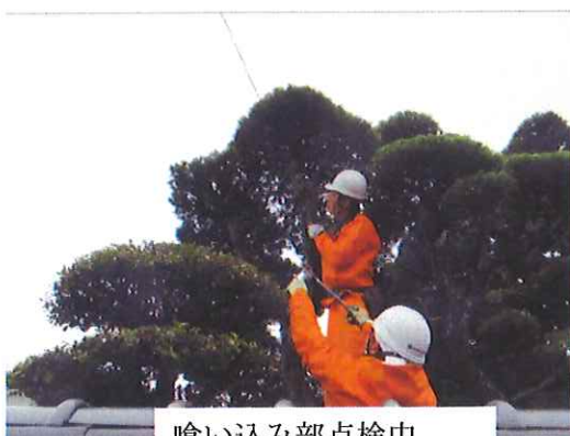
喰い込み部点検中
