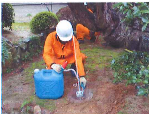
透水試験作業中
