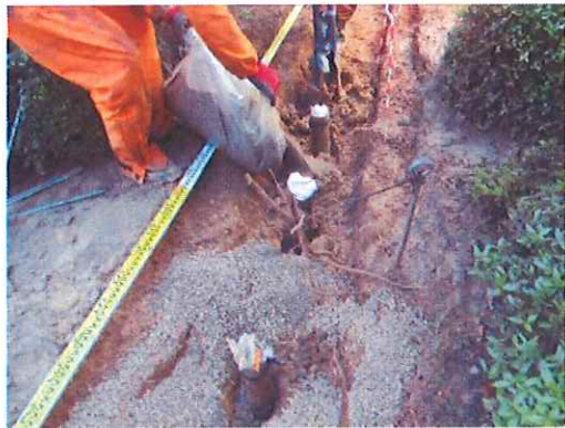
割竹、改良材、の投入
