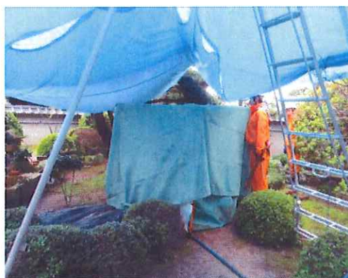
防塵飛散防止ネット
