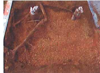
清浄改良土敷き均し
