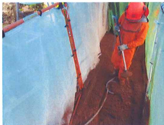
エアースコップ2本(飛散防止ネット設置)
