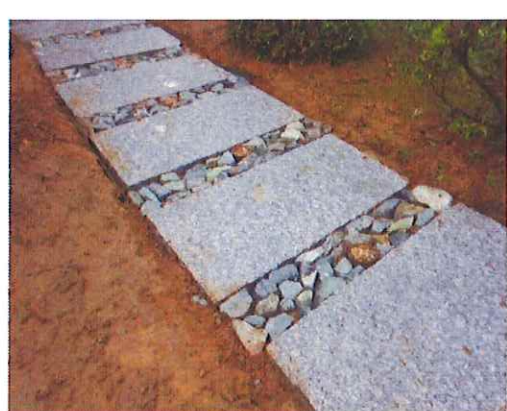
石板敷設、割栗石打ち込み完了
