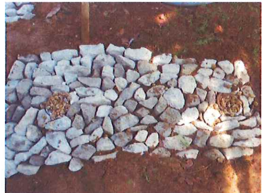
南側ピット割栗石等敷設
