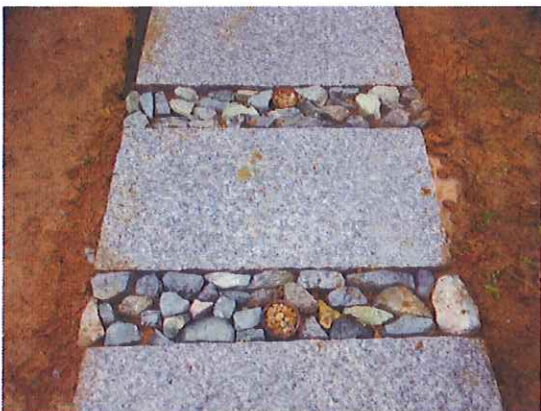
石板敷設、割栗石打ち込み完了
