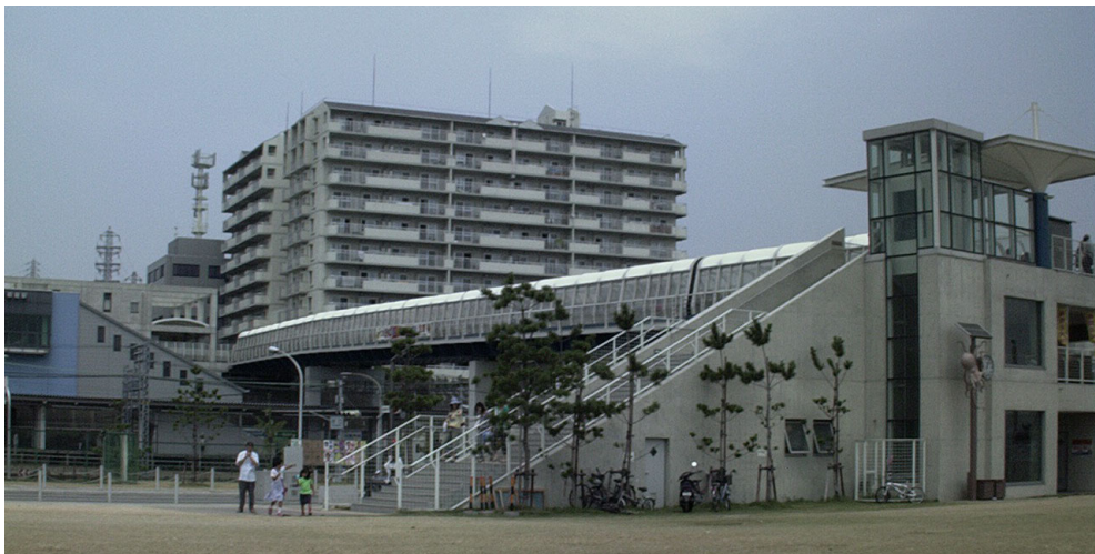
(大蔵海岸側から見た朝霧歩道橋)
