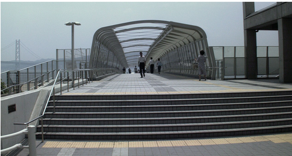
(朝霧歩道橋の北側朝霧駅方面からの入り口)
