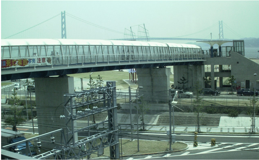
(朝霧駅側から見た朝霧歩道橋)
