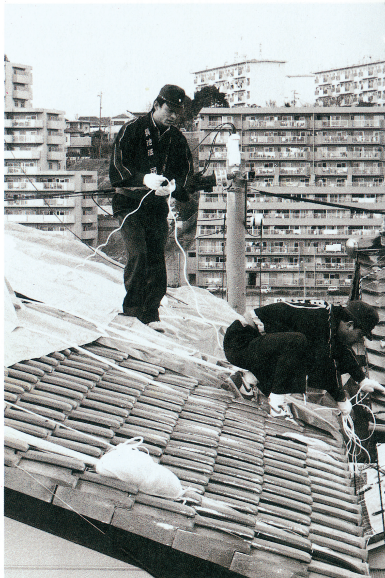
屋根のシート張りをする消防団員(大蔵谷)
