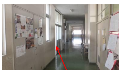
連絡通路出入口
