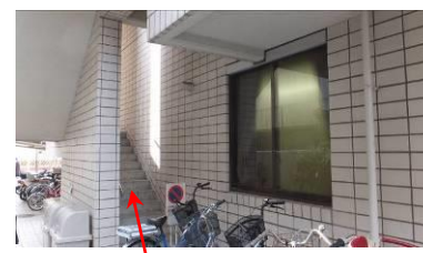
非常階段 1階部分
