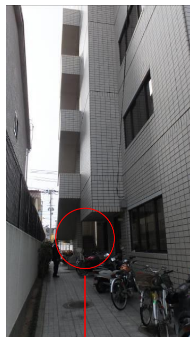
建物東側非常階段
